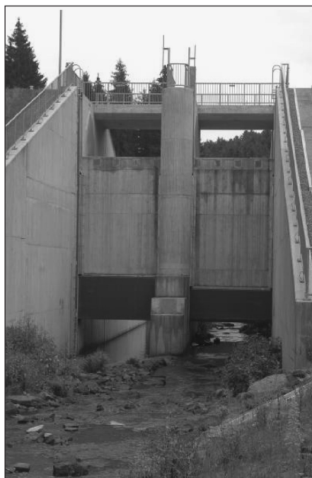
Фиг. 12. Екологично проходимо изпускателно съоръжение на РБВВ на река Лаутер при Глаттен, работен изпускател (ляво) и екологично речно корито (дясно) Fig. 12. Environmental passable exhaust facility on the river Lauter RBVV in Glatten, business outlets (left) and ecological watercourse (right)
