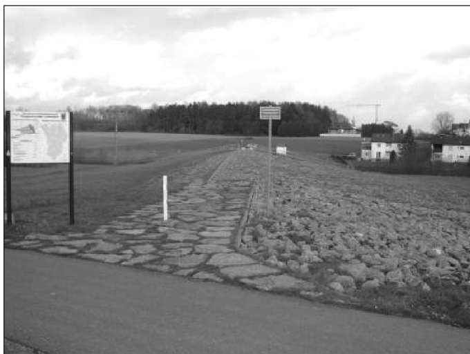
Фиг. 8. РБВВ Агластерхаузен на река Шварцбах – преливно преградно съоръжение Fig. 8. RBVV Aglasterhausen River Shvartsbah – partition overflow facility
