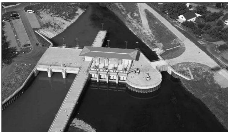
Фиг. 10. Помпена станция
