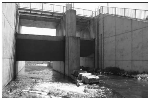
Фиг. 11. Екологично проходимо изпускателно съоръжение на РБВВ на река Зеках при Аделсхайм, работен изпускател (ляво) и екологично речно корито (дясно) Fig. 11. Environmental passable installation of exhaust RBVV River in Zekah Adelshaym, business outlets (left) and ecological watercourse (right)
